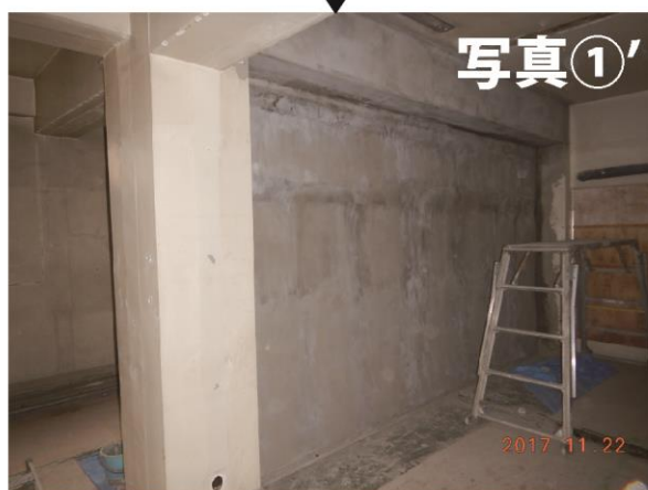
RC壁補強による補強工事 (写真：東館1Fの耐震補強)
