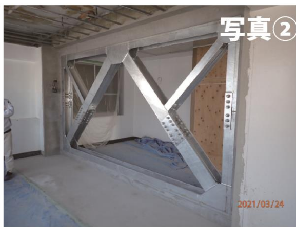
耐震ブレスによる補強工事 (写真：東館2Fの耐震補強)
