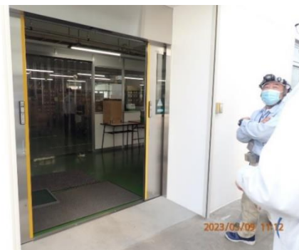
ナブコシステムサービスマンによる目視点検
