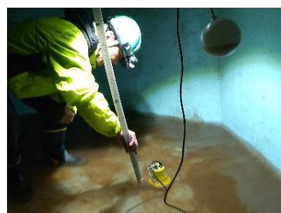
槽内底床の清掃→ 作業
