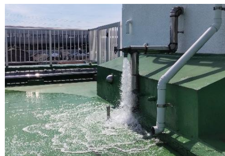
屋上での放水→
